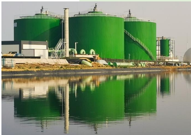
中温厌氧发酵罐 5000\text{m}^3 \times 4 座，立式搅拌，排砂、排浮渣；氨氮上限达6500ppm
